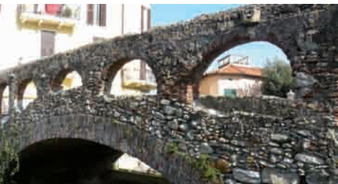
Un tratto del Beo del Principe lungo il Ponte Romano
